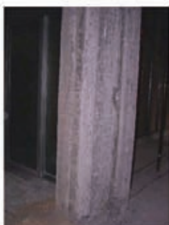
Pilastro P. 18: Pilastro 34, III piano F.L. via Est
