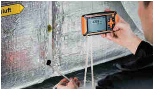
Misura con tubo di Pitot in un condotto
